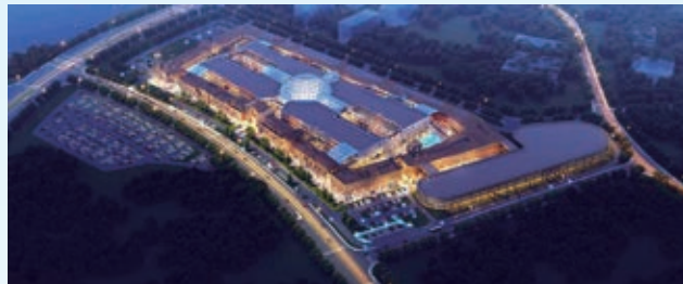
杭州首創奧特萊斯的光伏發電系統
